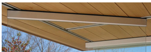
Bahnhof integriert in Decke
