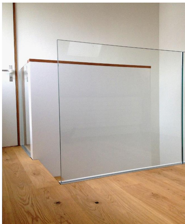
Ganzglasgeländer bodeneben im Innenbereich
