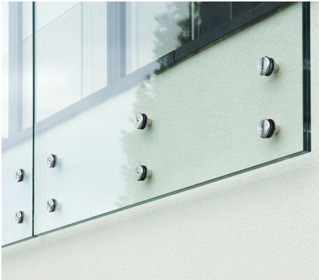
formschöne Edelstahlpunkthalter mit 50 mm Durchmesser
