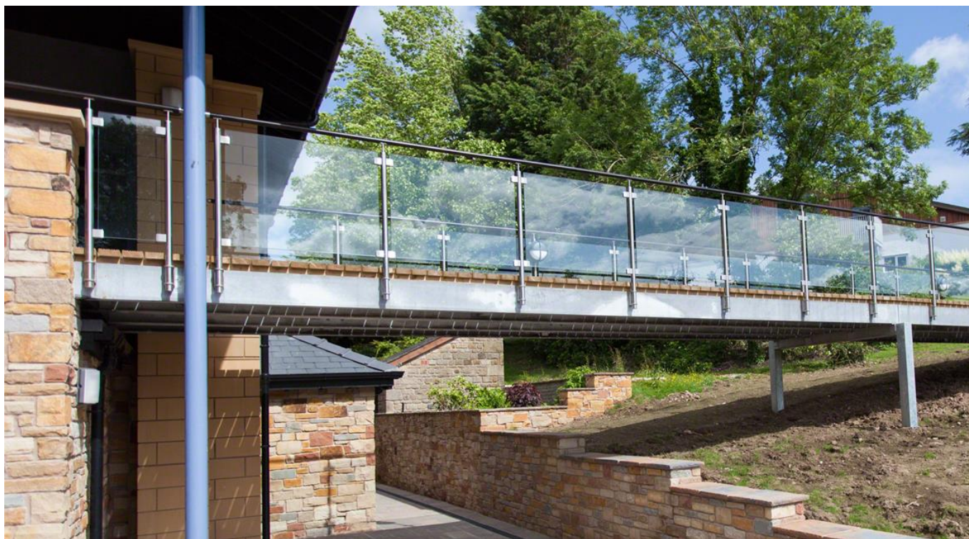
Glasgeländer mit Pfosten in runder Ausführung und transparenter Glasfüllung
