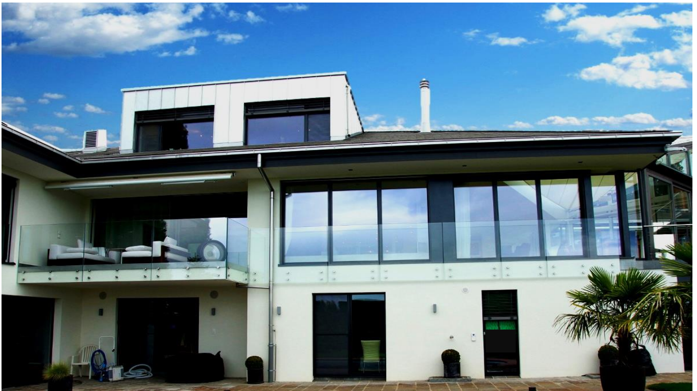
Ganzglasgeländer mit Punkthalter an Fassade
