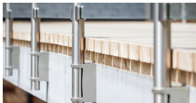
stirnseitig auf Beton montierte Geländerpfosten
